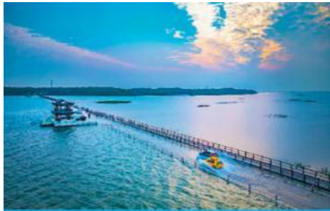
ถนนลอยน้ำ
