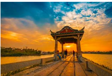
สะพานอันผิง
