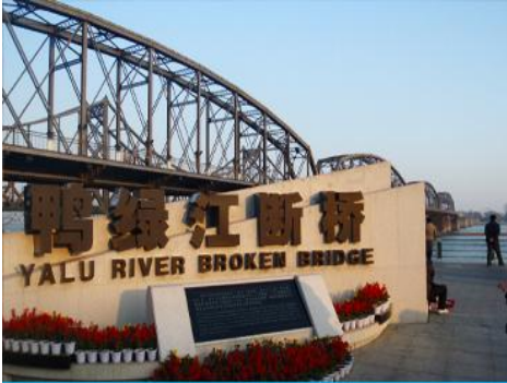
สะพานขาด
